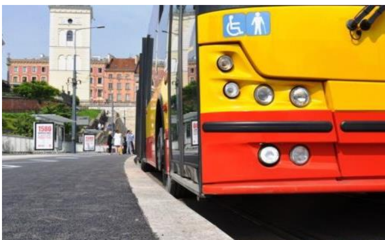
Rysunek 69 Przykład wyniesienia krawędzi przystanku do krawędzi podłogi (tzw. przystanek Wiedeński)
