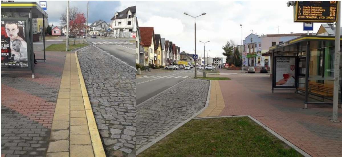
Rysunek 70 Wyposażenie infrastruktury przystankowej w płyty sensoryczne
