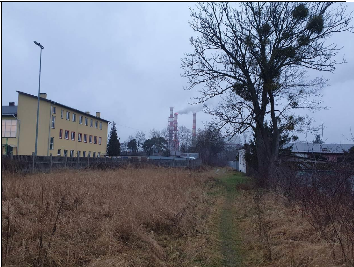
Fot. 5 Widok na budynek hali od strony wschodniej i położone w oddali kominy Elektrowni Ostrołęka (fot. własna)
