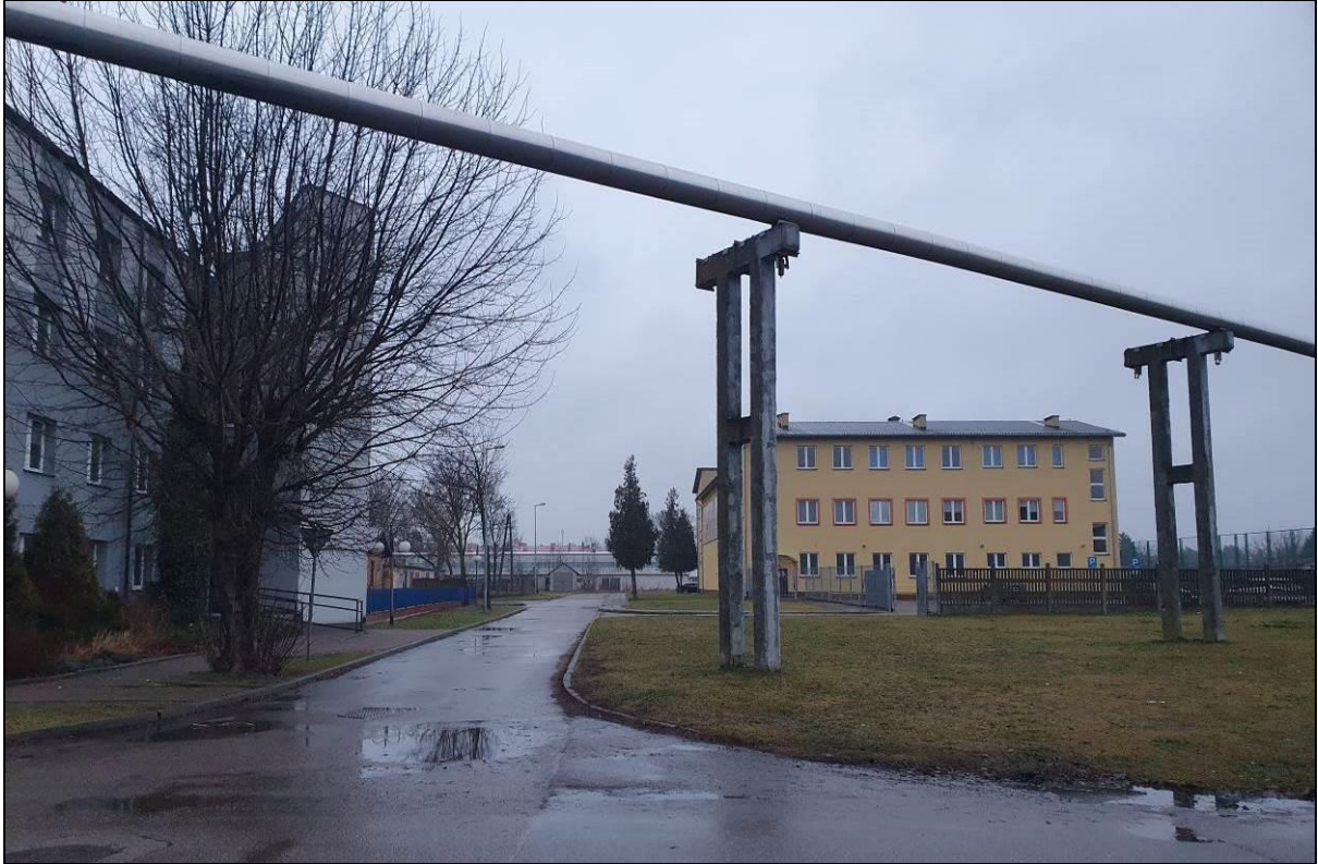
Fot. 1 Widok na napowietrzny ciepłociąg i budynek hali sportowej – od strony zachodniej obszaru (fot. własna)
