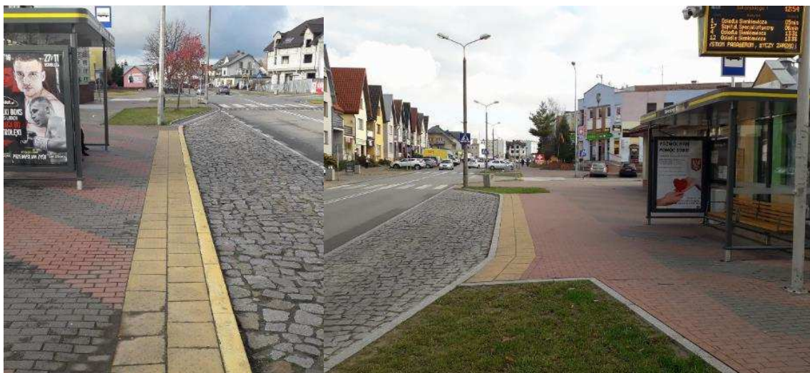
Rysunek 70 Wyposażenie infrastruktury przystankowej w płyty sensoryczne
