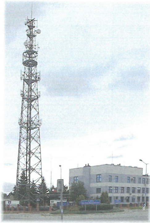
Fot. 1. Linia radiowa / Ostrołęka - widok wieży z anteną LR
