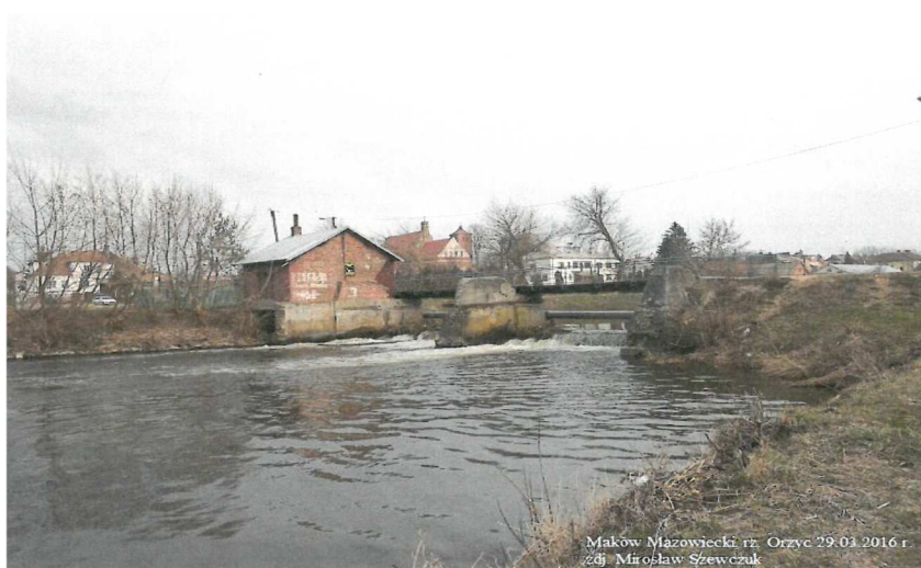
Maków Mazowiecki, rz. Orzyc 29.03.2016 r. zdj. Mirosław Szewczuk Obiekt byłej elektrowni wodnej, na rz. Orzyc w km. 24+100. Maków Mazowiecki
