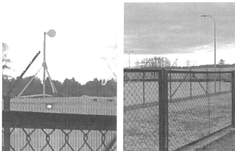
Widok obiektu wraz z zainstalowanym zespołem antenowym
