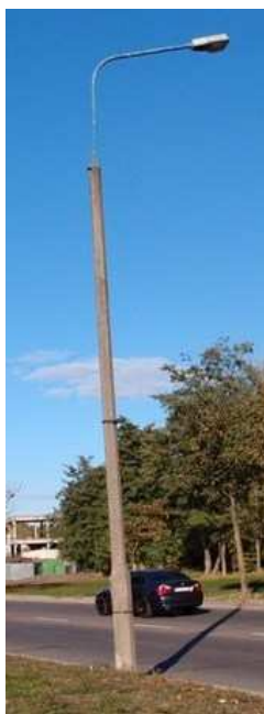
istn. słupy WZ-9,5 i S-80 do demontażu
