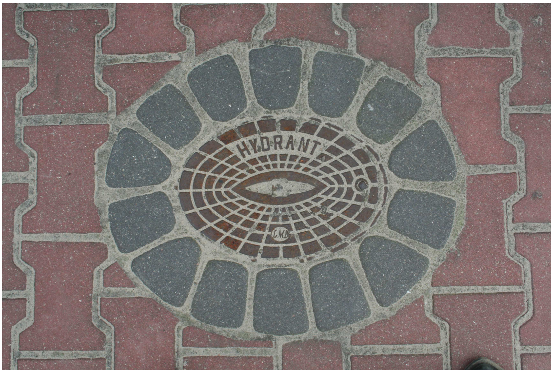
Fot. nr 8 Wykończenie nawierzchni jezdni w obrębie hydrantów podziemnych
