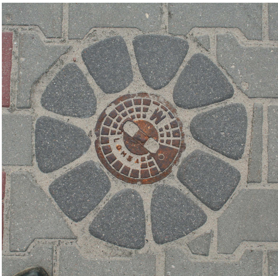
Fot. nr 9 Wykończenie nawierzchni jezdni w obrębie zaworów wodociągowych
