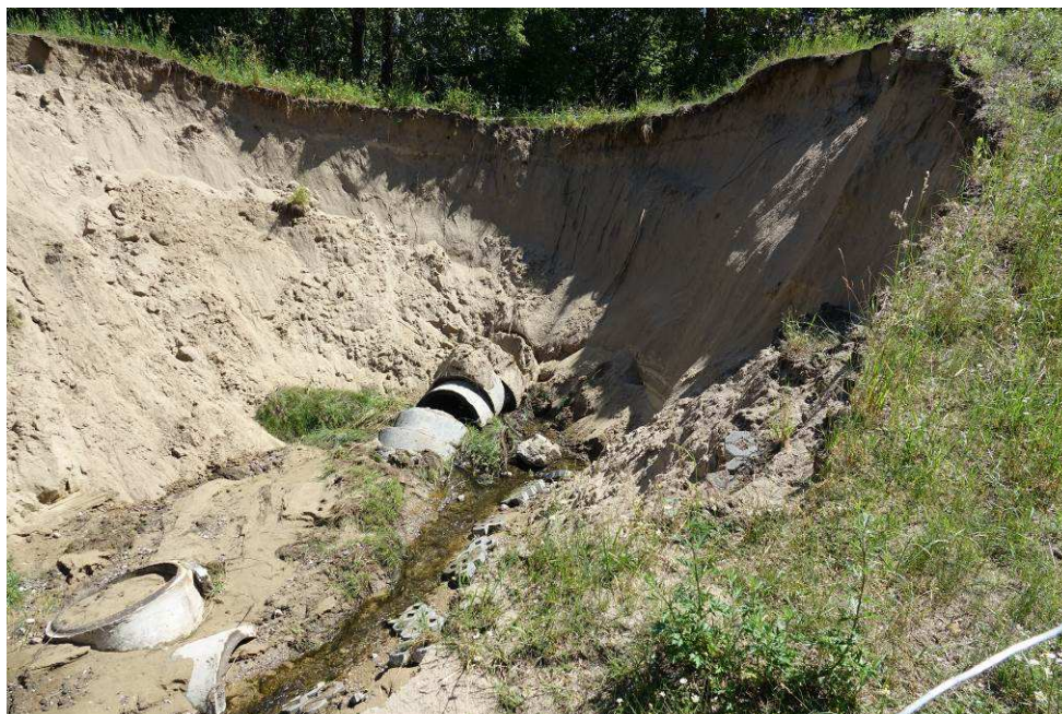
Fot. 11 Rurociąg przepustu.
