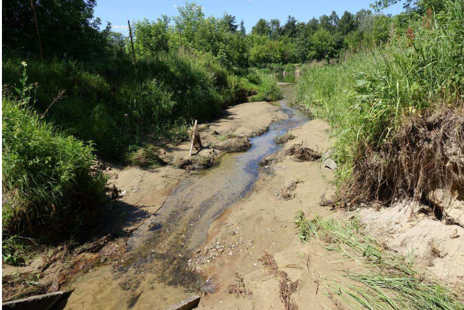
Fot. 15 Kanał odpływowy. Widok od strony wylotu przepustu w stronę koryta Narwi.
