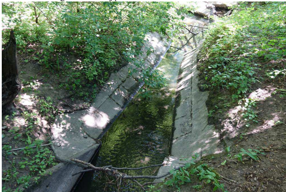
Fot. 5 Umocnienia dna i skarp kanału dopływowego do przepustu wałowego.
