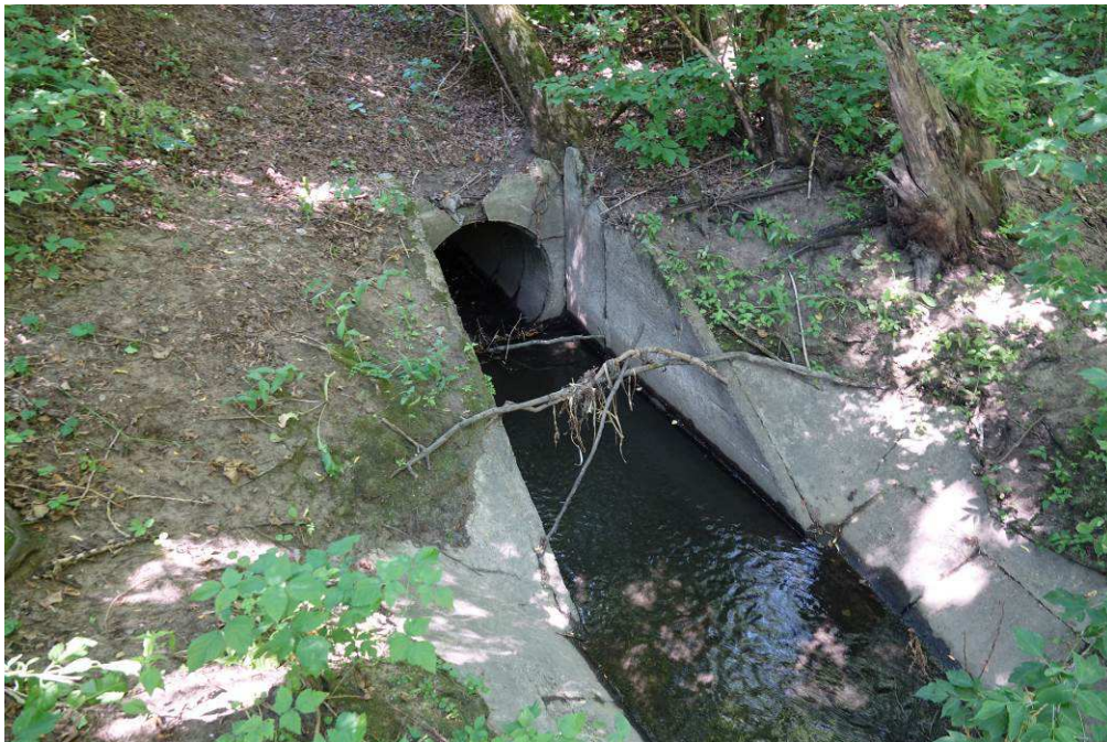
Fot. 9 Wlot do przepustu wałowego
