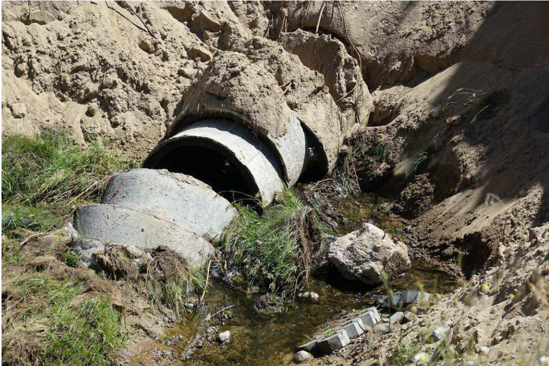
Fot. 12 Rurociąg przepustu.
