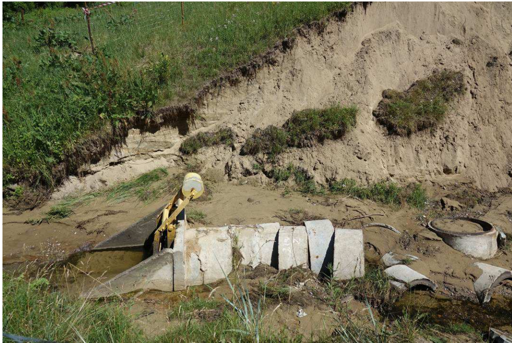
Fot. 13 Wylot przepustu wałowego. Widok z boku.
