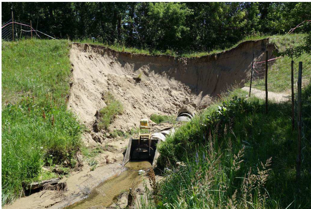
Fot. 10 Rurociąg przepustu.
