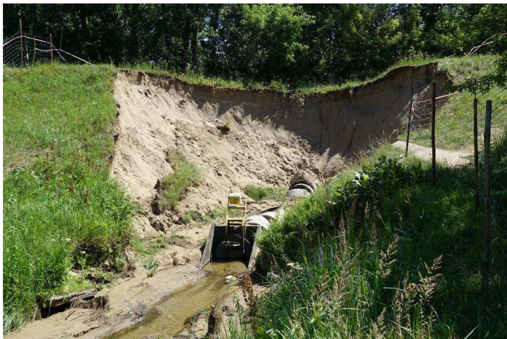
Fot. 14 Wylot przepustu wałowego. Widok od strony kanału odpływowego.
